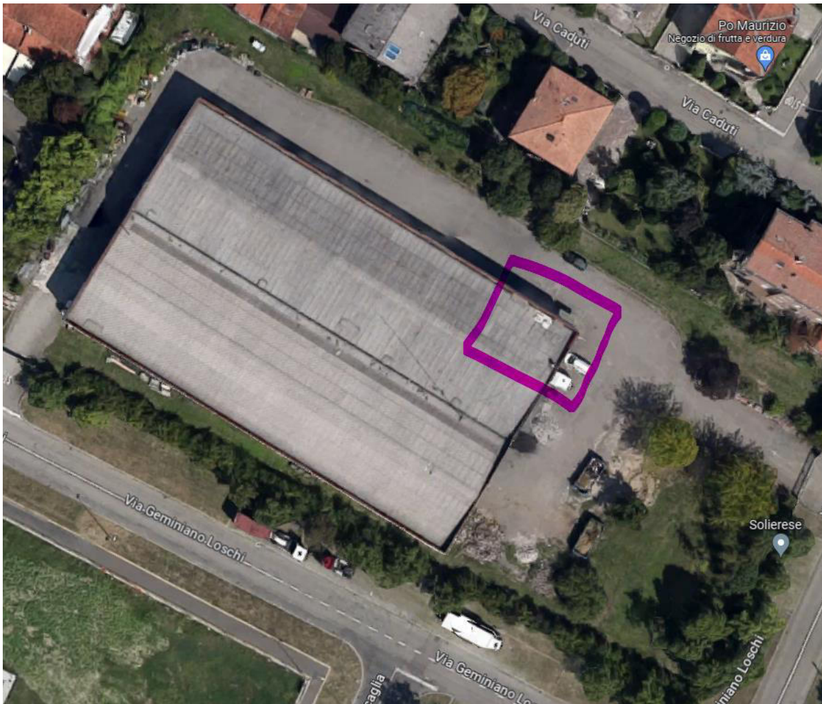
Identificazione zona cabina elettrica all'interno dell'ex deposito comunale
