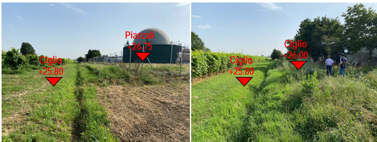
Figura 16: Rilievo GPS dell'area oggetto di studio – Fosso interpodereale oggetto di riprofilatura in area aziendale per realizzazione dell'invaso di laminazione a cielo aperto
