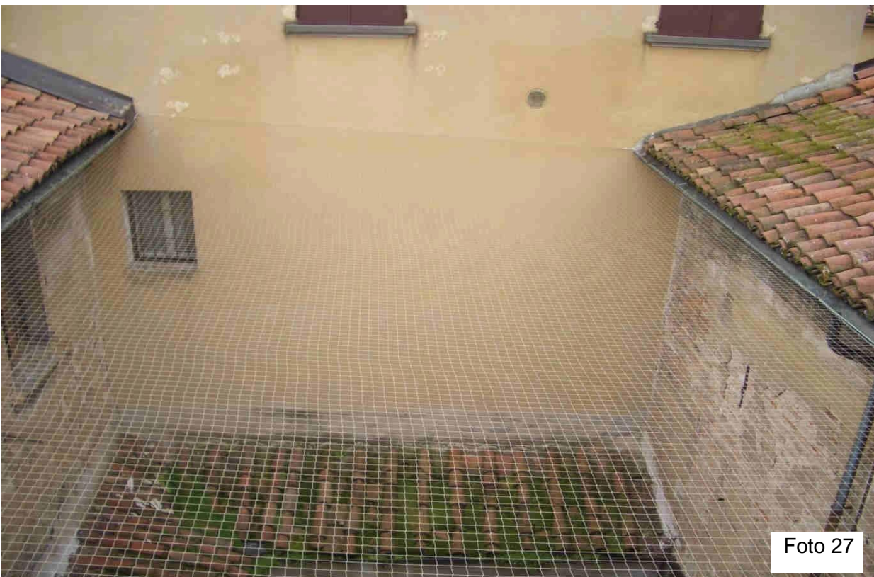
Foto 26 - In questa foto si propone la corretta soluzione per la problematica evidenziata nella foto 21. Foto 27 - I cortili interni colonizzati dai colombi, a causa delle difficoltà di accedervi per le operazioni di pulizia, diventano problematici. La rete impedisce l'accesso ai volatili e permette di mantenere condizioni igienico sanitarie accettabili.
