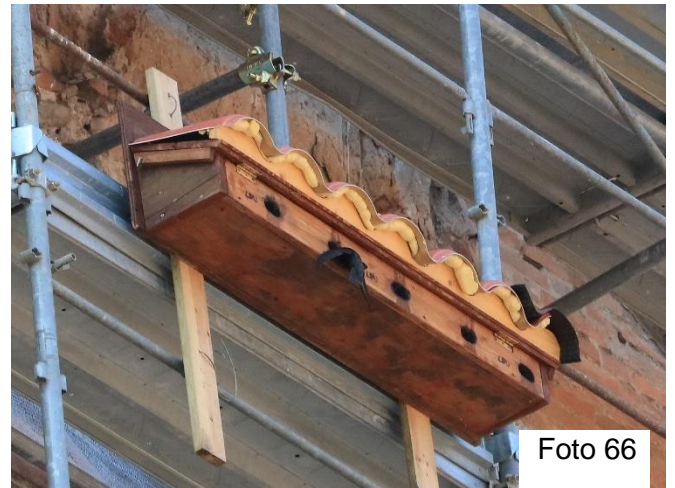
Foto 66 - Cassette nido per rondoni montate provvisoriamente in un cantiere
